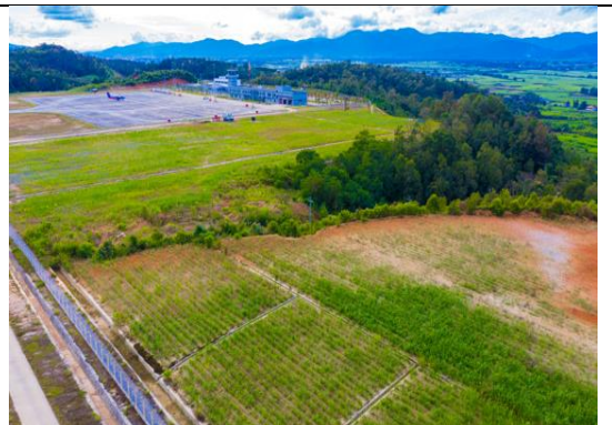
照片 32 临时表土堆场绿化
