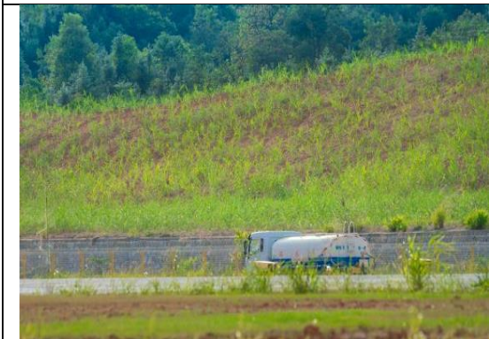
照片 31 南端水库一侧边坡绿化
