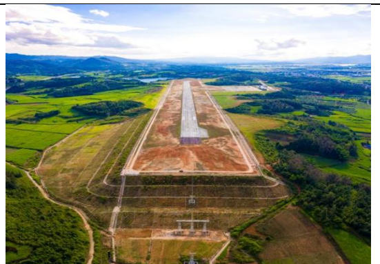
照片 30 边坡排水沟
