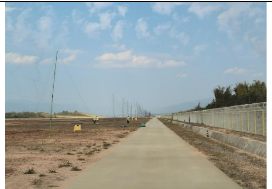
照片 22 航站区内部巡查道路
