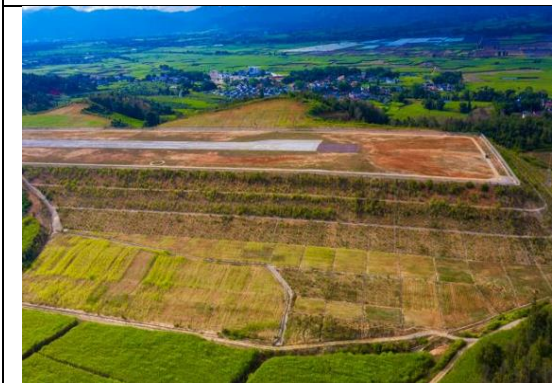
照片 29 马道排水沟
