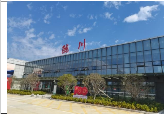
照片 11 航站楼外部
