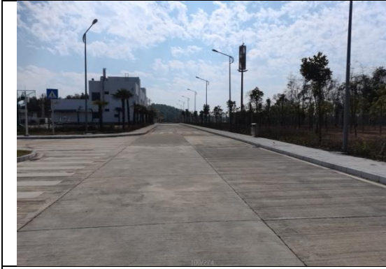
照片 1 进场道路
