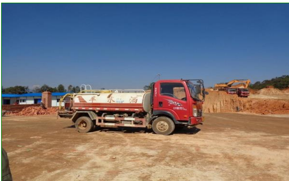
图 6.2-1 项目施工期大气环境保护措施（施工期场地洒水）
